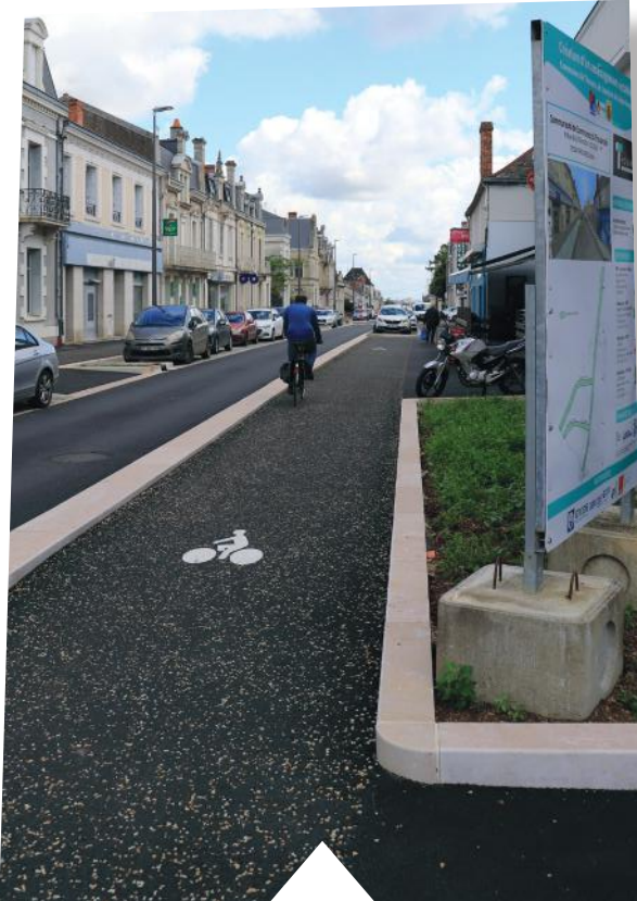
Travaux achevés pistes cyclables Avenue Victor Leclerc
