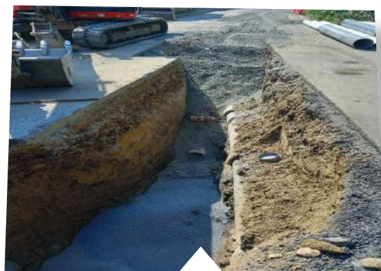
Démarrage des travaux de mise en séparatif du réseau sur le système d'assainissement de Cersay, Commune déléguée de Val-en-Vignes.
